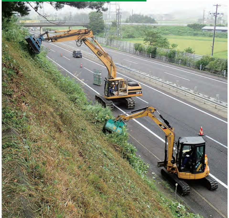
クサカルゴンを用いたのり面の草刈作業
