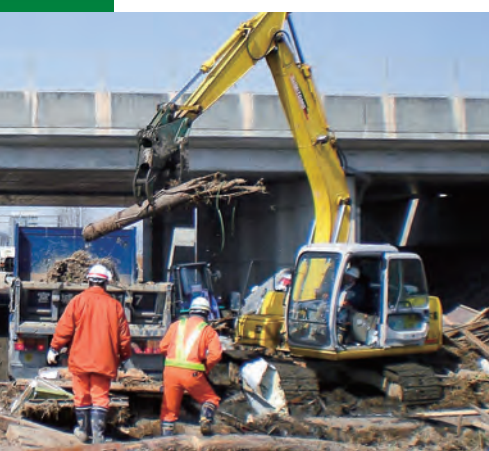
東日本大震災による応急復旧工事
