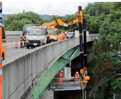
橋梁補修工事
