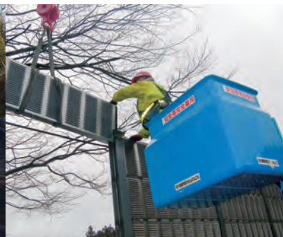
遮音壁取替工事
