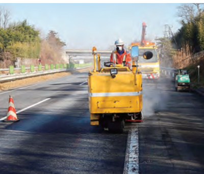
舗装補修工事
