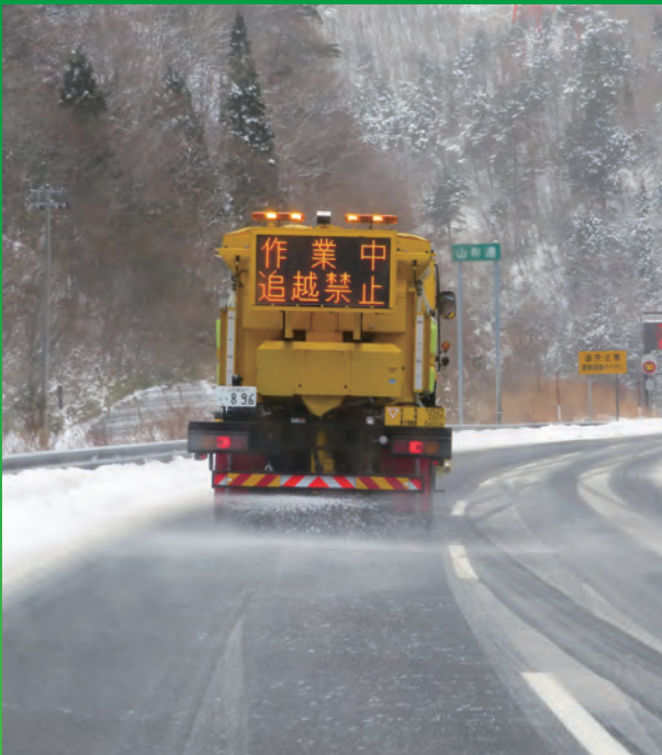
凍結防止剤散布作業
