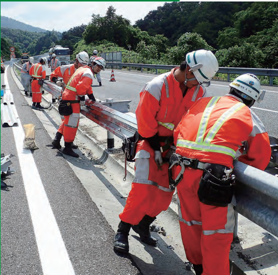
ガードレール復旧工事
