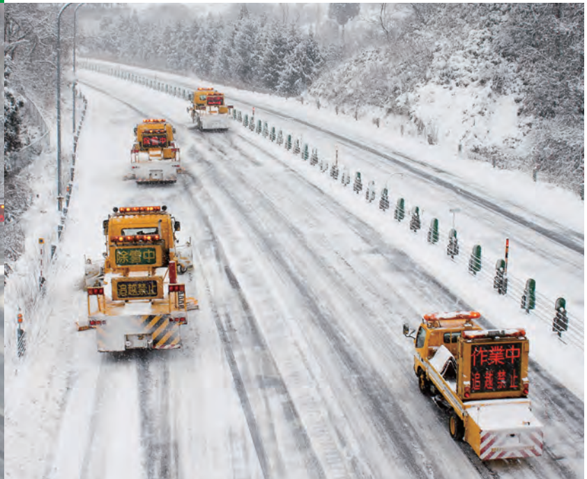
梯団除雪作業
