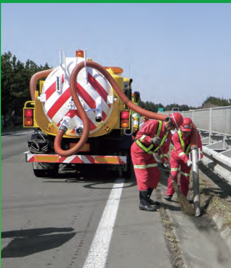
排水こう清掃(ロールドガッター)
