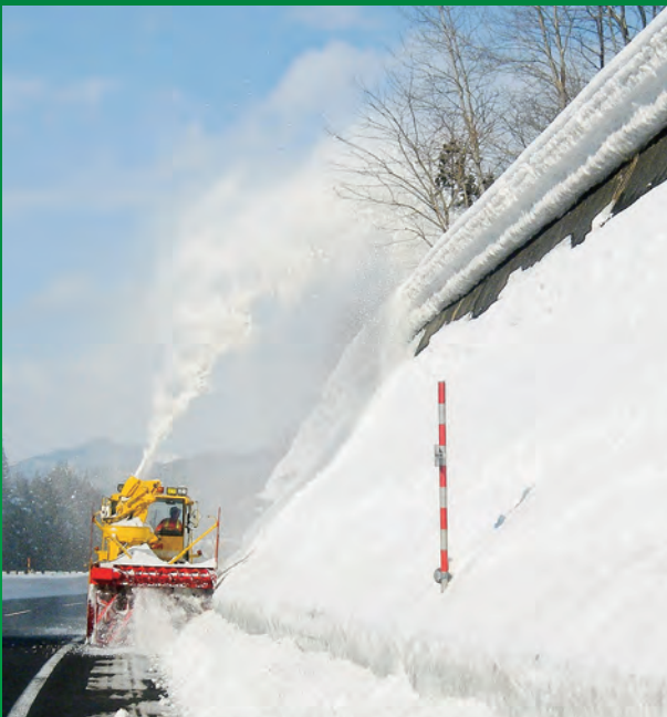
ロータリー除雪作業
