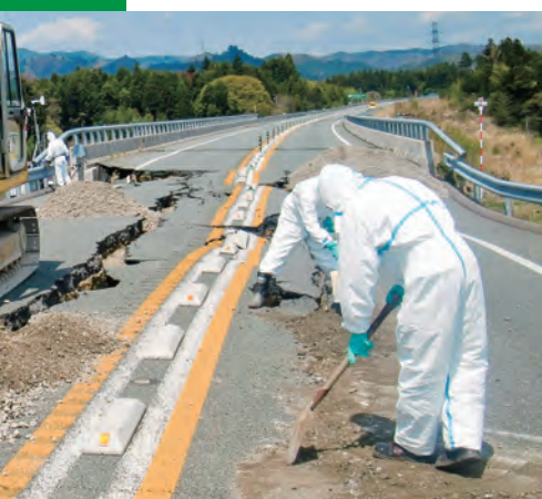
東日本大震災による応急復旧工事
