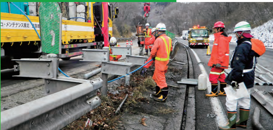
ガードレール復旧工事
